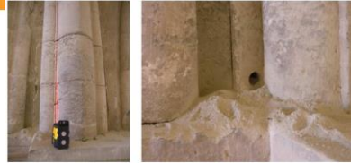
Perforació realitzada al costat del nervi central sobre la cornisa, aproximadament a 50cm d'alçada respecte la rasant del pati exterior.
